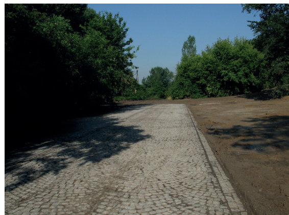
Ryc. 12. Trakt Sandomierski, widok ogólny odtworzonej kamiennej nawierzchni z początków XX wieku. Fot. J. Bober
